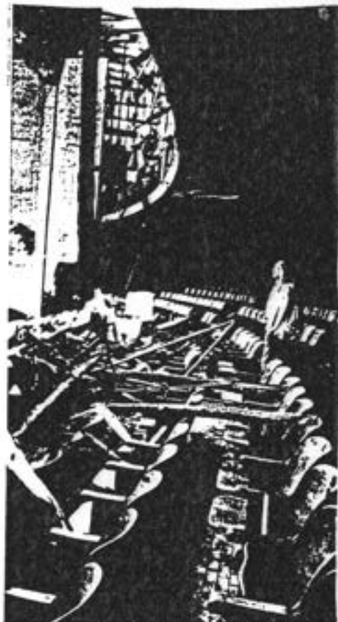
Restos do TUCA após o incêndio
